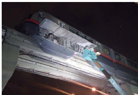
高所作業車を使用した車両点検
