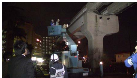
高所作業車を使用した線路点検
